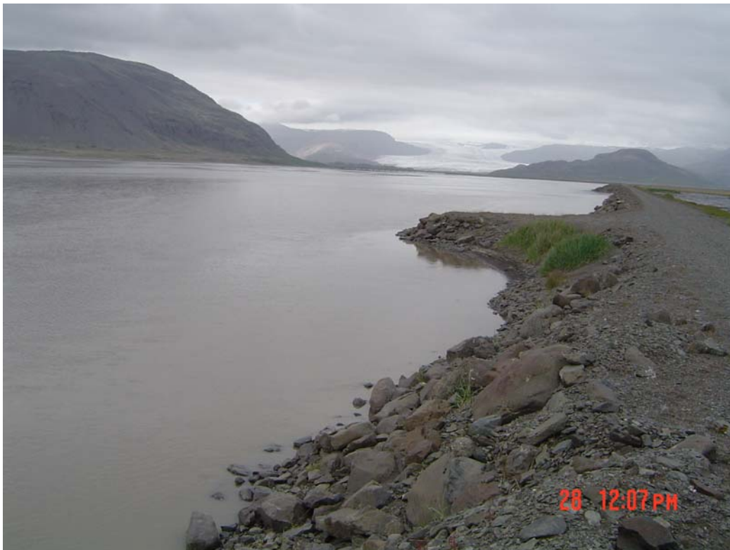
9. mynd. Hornafjarðarfljót. Varnargarður að Skógey og brú á núverandi Þjóðvegi með jökul í baksýn.
