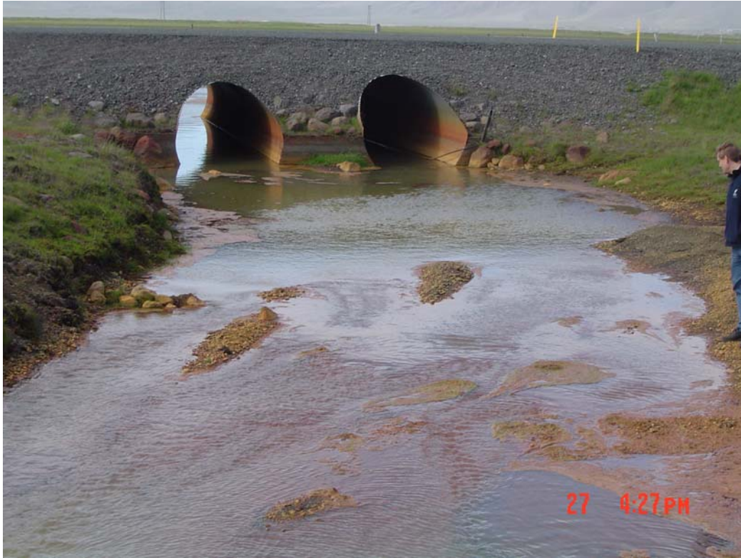
2. mynd. Brunnhólsá ræsi undir núverandi veg.
